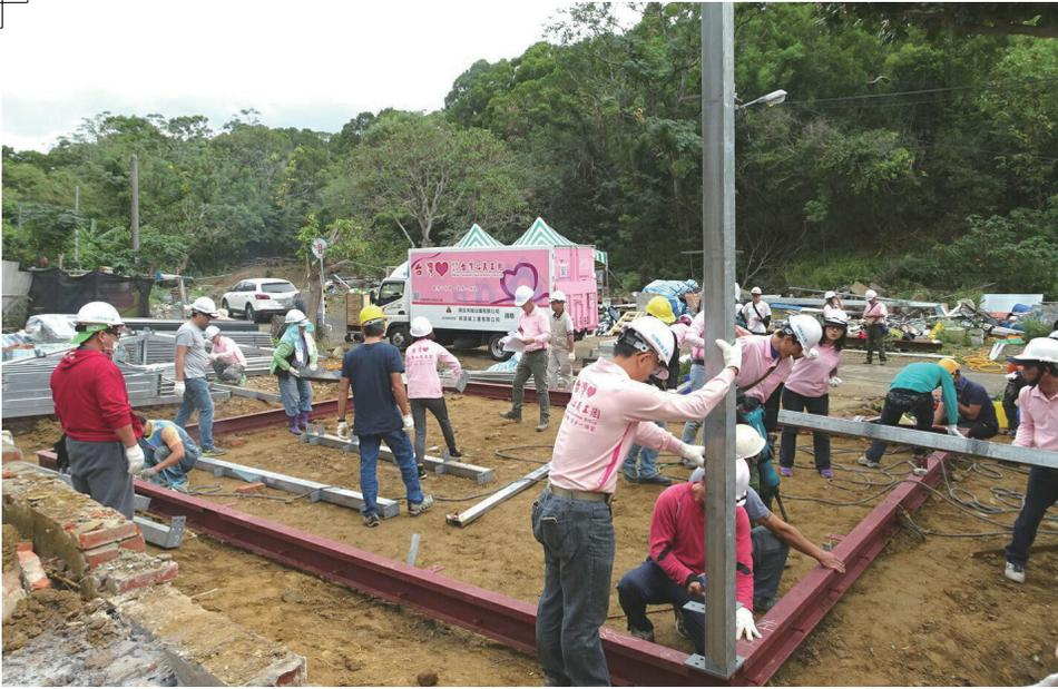
家屋重建前置作業：將鋼骨結構組合，處理水電配置、鐵工浪板、灌漿（台灣心義工團提供）
