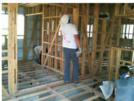
災區的房屋受害甚大，不只木匠不足連建材也不足。須要專業者修理的地方 由臺灣來的木工技師們修理。
