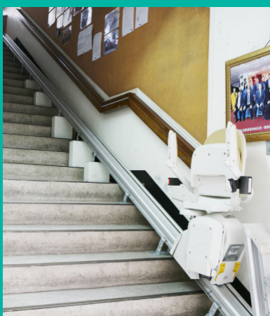
小港教會無空間建設電梯，遂加裝升降椅，打造無障礙空間。
